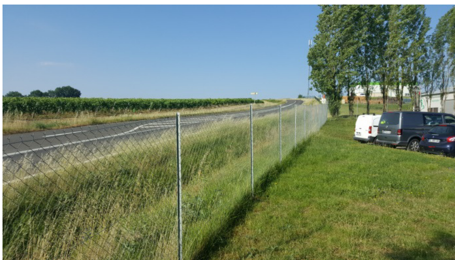
Photo n°3 : Fossé de la RD 931
